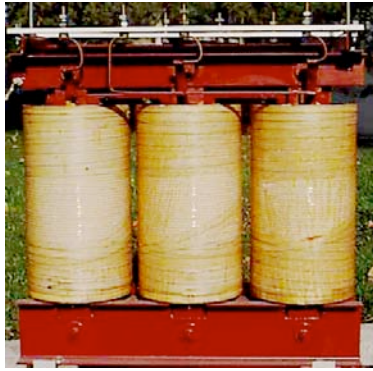
Figure 6.26 : exemple de transformateur triphasé plan à trois colonnes (coupe France Transfo).
